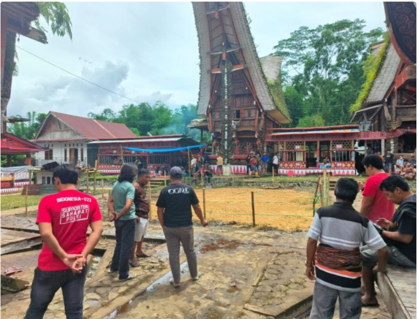
Pembongkaran Arena Judi Sabung Ayam di Sangalla
